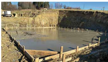
48. Rozbudowa sieci wodociągowej na roli Stachurówka w Skawie
