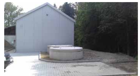
42. Stacji uzdatniania wody na potoku Kosiczne w Rabie Wyżnej
