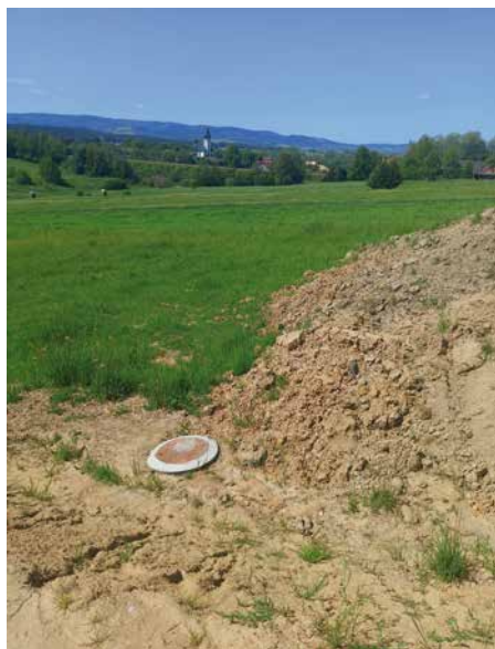
45. Budowa kanalizacji w Rokicinach Podhalańskich
