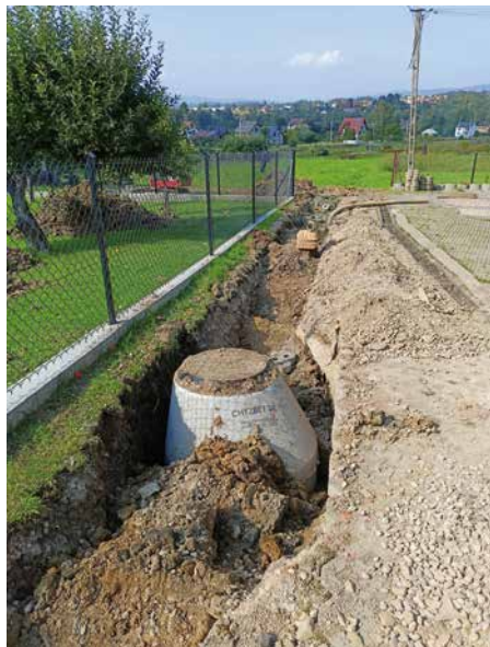
44. Budowa kanalizacji w Rabie Wyżnej
