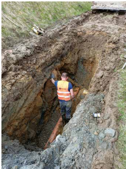
47. Budowa kanalizacji sanitarnej w Skawie
