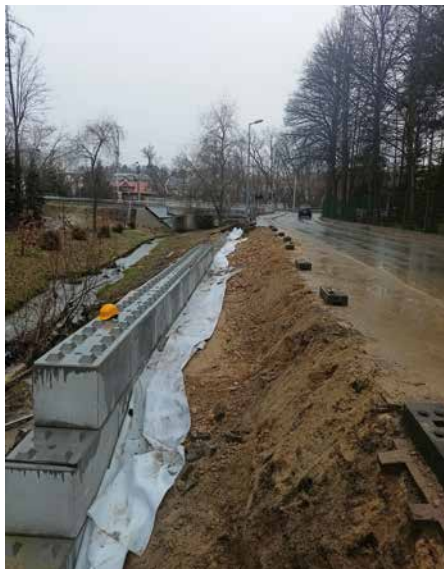
55. Poszerzenie drogi gminnej w Rokicinach Podhalańskich
